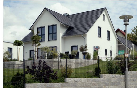
Foto links und oben: von der Helmut Herrmann Bauunternehmen GmbH und Tochterfirma HH-Wohnbau GmbH realisierte Wohnräume.
